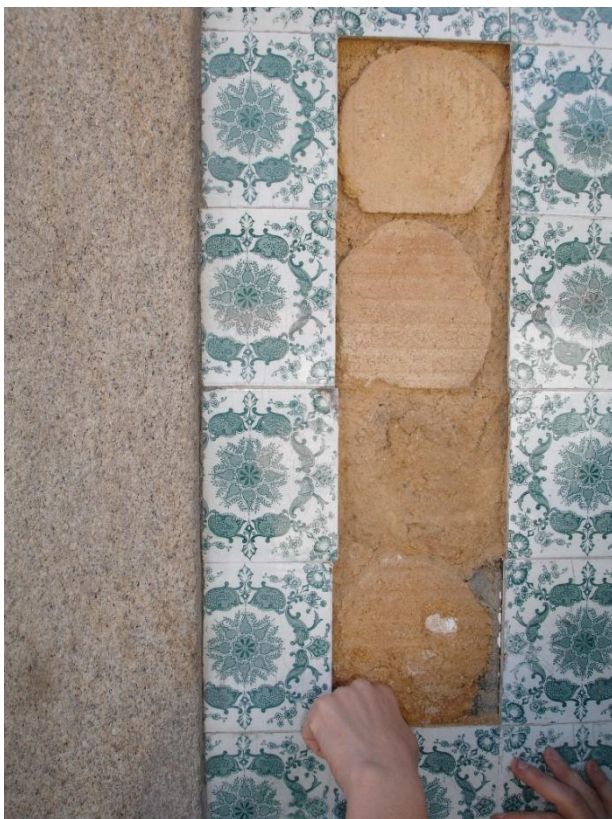
Remoção dos azulejos
