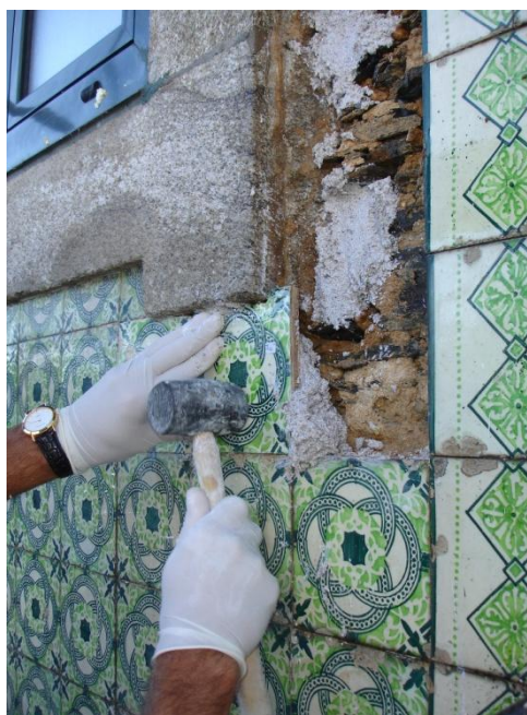
Recolocação de azulejos
