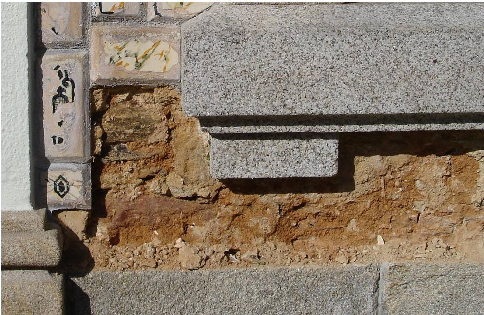
Após remoção da argamassa de emboço
