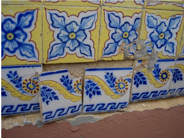
Durante a remoção dos azulejos
