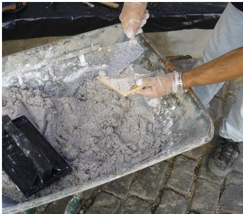
Aplicação de argamassa no tardo do azulejo para recolocação na fachada
