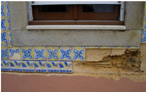
Aspecto da parede após remoção de azulejos e das argamassas
