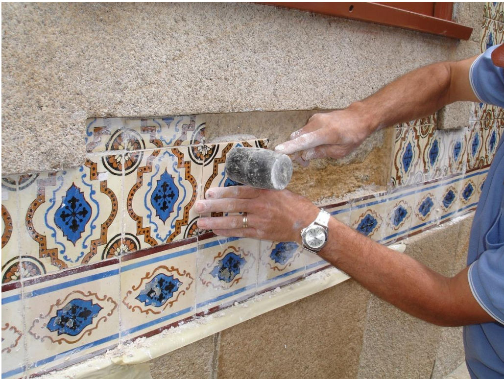
Recolocação dos azulejos na fachada
