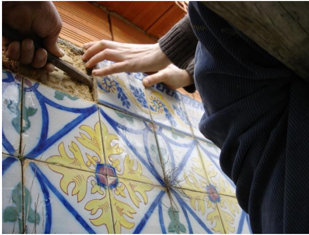
Remoção dos azulejos da fachada
