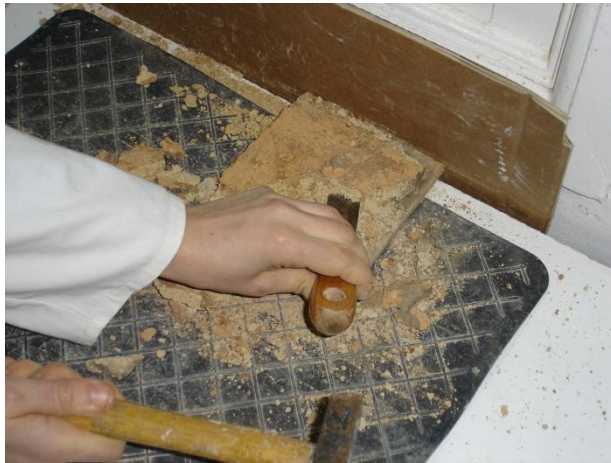
Remoção das argamassas do tardo
