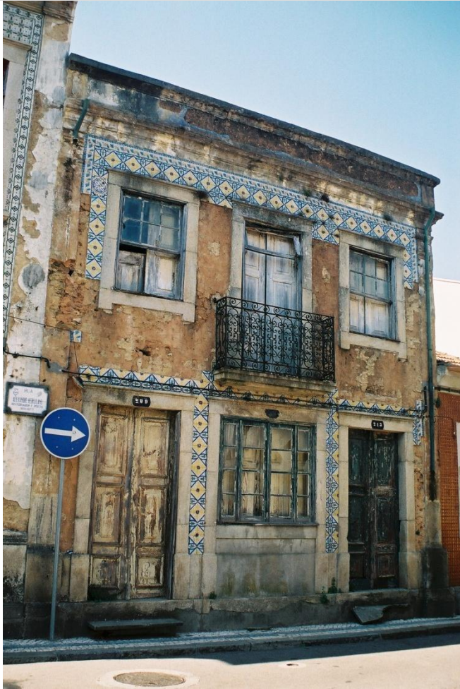
Aspecto geral da fachada antes do início da recuperação do edifício
