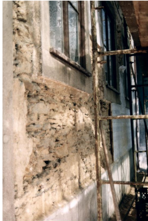
Aspecto da fachada após a remoção do revestimento cerâmico
