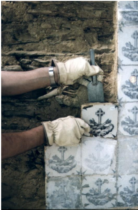
Remoção de azulejos após aplicação do faceamento
