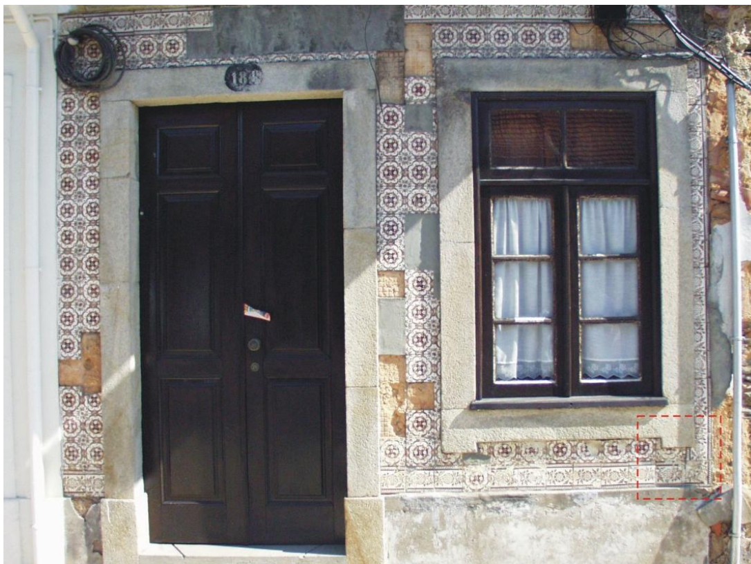
Aspecto geral da fachada em 2003
