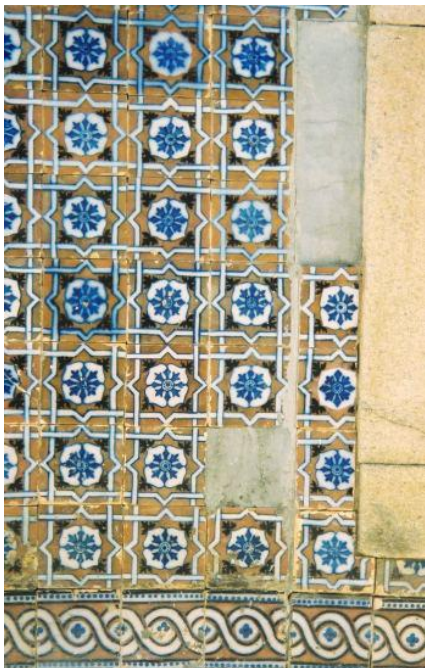
Lacunas de azulejo, preenchimentos com cimento e lacunas de vidro.
